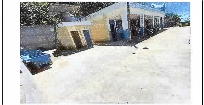
Foto 6: Patio sustitucion de torta de concreto
