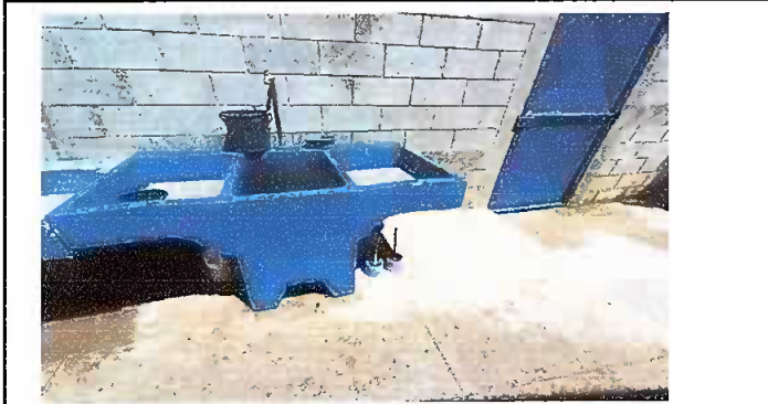
Foto 3: Modulo 2. sustitucion de pila de cemento.
