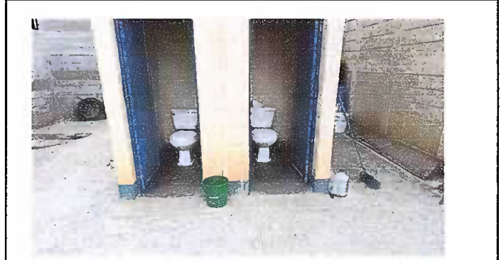
Foto 4: módulo 3 Sustitucion de inodoro
