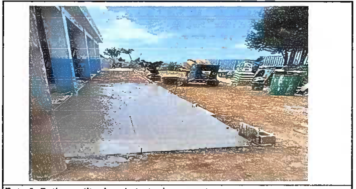
Foto 6: Patio sustitucion de torta de concreto
