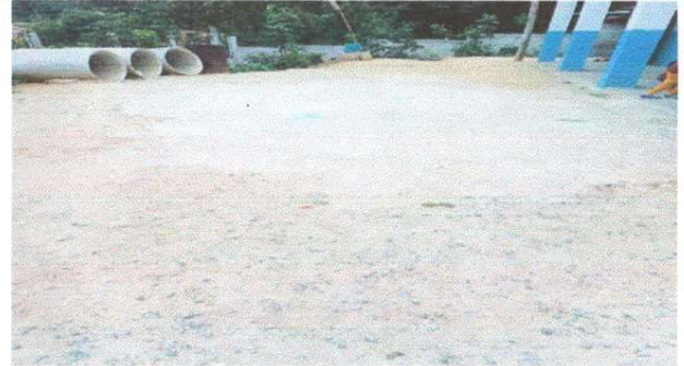
Foto 6: Patio sustitucion de torta de concreto
