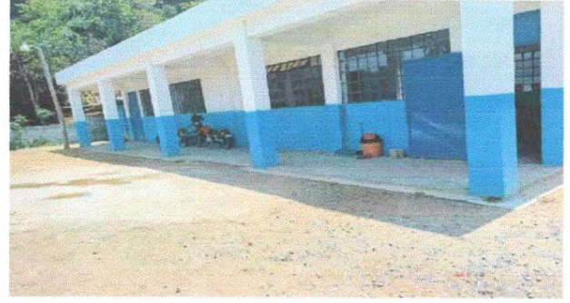
Foto 2: modulo 1 suministro e instalacion de balcones en ventanas de metal.
