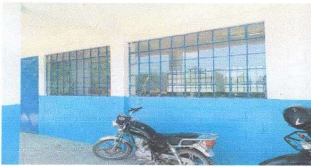
Foto1: Modulo 1, suministro e instalacion en balcones de ventanas de metal.
