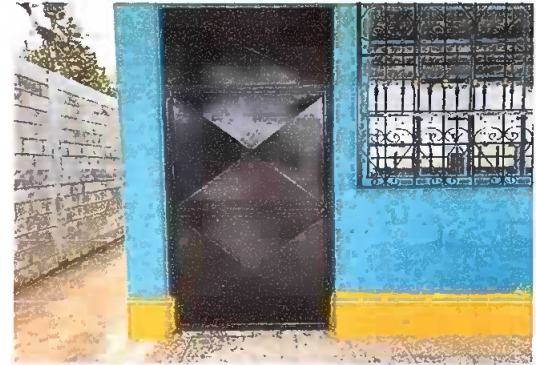
Foto 2: Mantenimiento de puertas de metal
