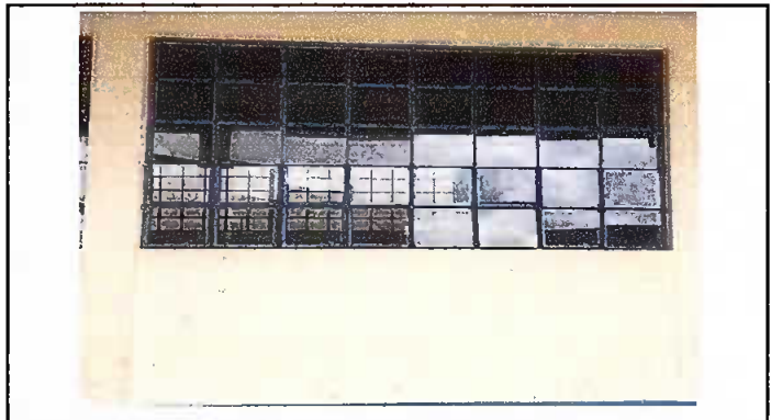
Foto 4: Suministro e instalaciòn de balcones de metal
