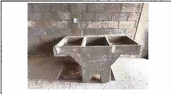
Foto 3: Sustitucion de pila de cemento de dos labaderos
