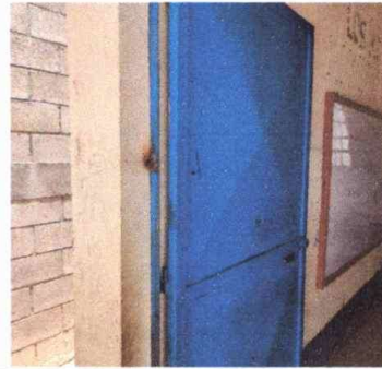
Foto 2: Sustitucion de puertas de metal
