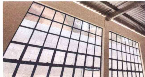
Foto 4: Suministro e instalaciòn de balcones de metal
