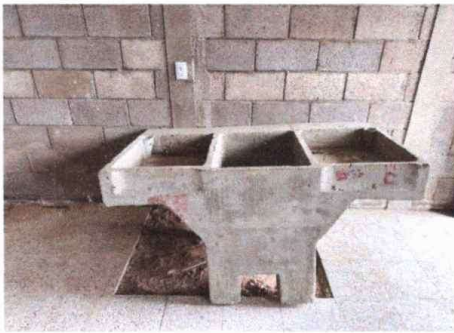
Foto 3: Sustitucion de pila de cemento de dos labaderos
