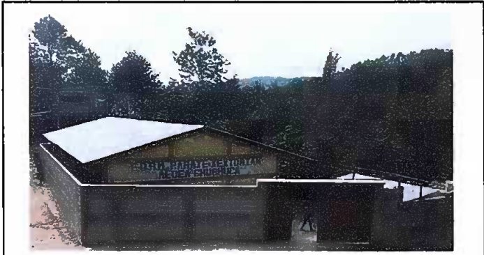
Módulo 1: Foto1: Sustitución de lámina y capotes
