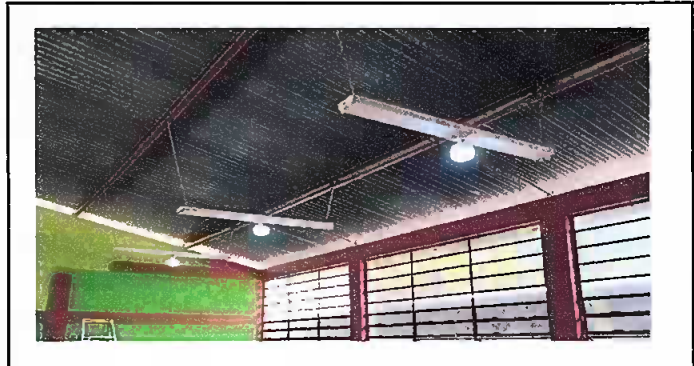
Módulo 1: Foto 4: Sustitución de plafonera, candelas por focos led y pintado de interiores del módulo.
