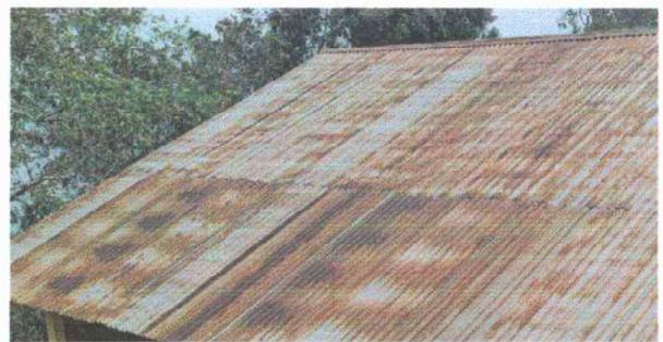
Modulo 2: Sustitución de lámina, por lámina troquelada aluzinc calibre 24
