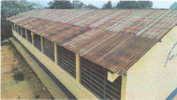
Modulo 1: Sustitución de lámina, por lámina troquelada aluzinc calibre 24
