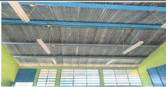
Modulo 1: Instalación de unidades luz (incluye interruptor, ducto y cable eléctrico)
