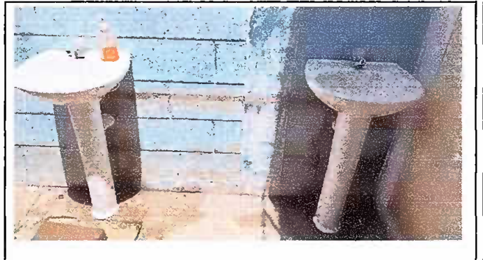
Foto 8: Instalación de lavamanos. Módulo 8
