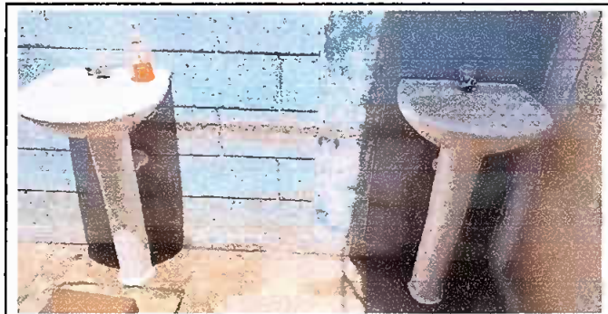
Foto 8: Instalación de lavamanos. Módulo 8
