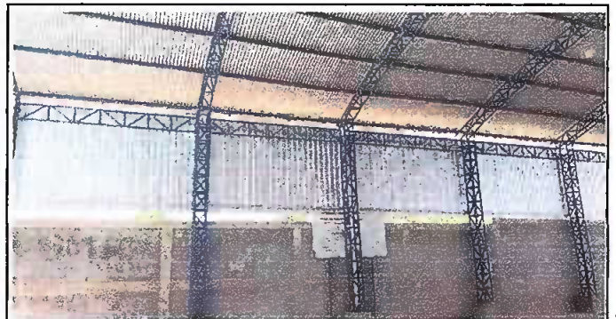
Foto 6: Sustitución de láminas de zinc por láminas troqueladas sobre techado. Módulo 6.
