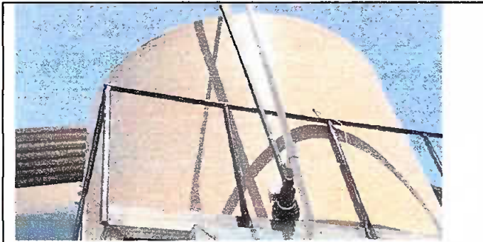
Foto 9: Instalación de tinaco. Módulo 9
