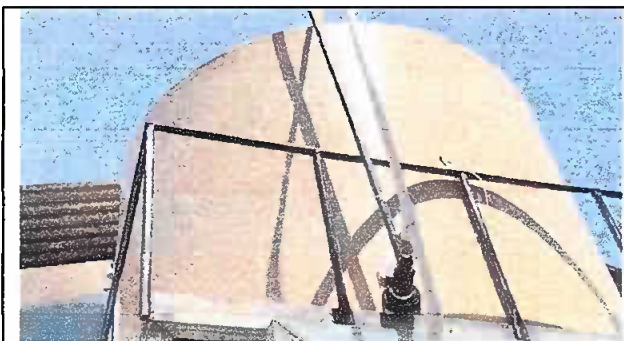
Foto 9: Instalación de tinaco. Módulo 9
