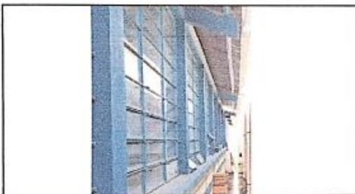
Foto 3: Instalación de vidrios. Módulo 2.
