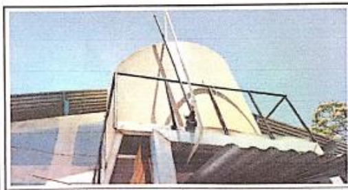
Foto 5: Instalación de estructura metálica para cisterna. Modulo 3.
