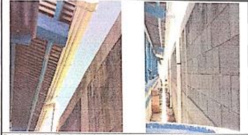
Foto 1: Instalación de canales de metal y colocación de bajadas de agua pluvial detrás de la escuela. Y elementos de fijación. Módulos 1 y 2.
