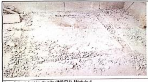
Foto 6: Instalación de pila (INSITU). Módulo 4
