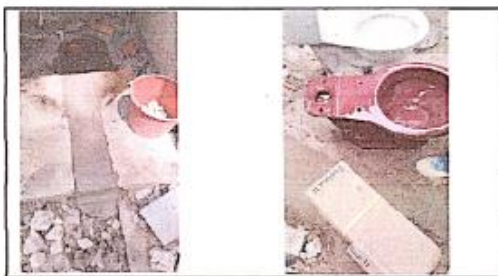
Foto 4: Sustitución de inodoros y tuberías de desagüe. Módulo 3.
