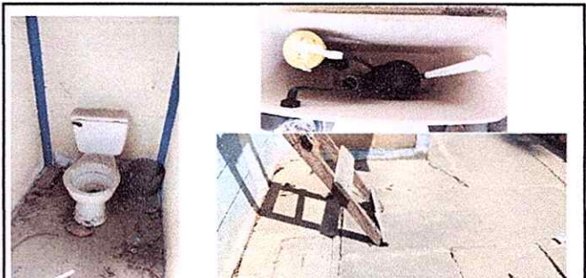
Foto 4: Sustitución de inodoros y tuberías de desagüe. Módulo 3.
