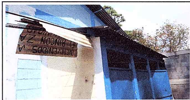
Foto 5: Baños, sustitución de láminas y elementos de fijación. Modulo 3.
