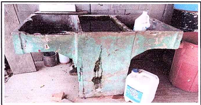
Foto 6: Reparación de pila. Mantenimiento y colocación de azulejos. Módulo 4
