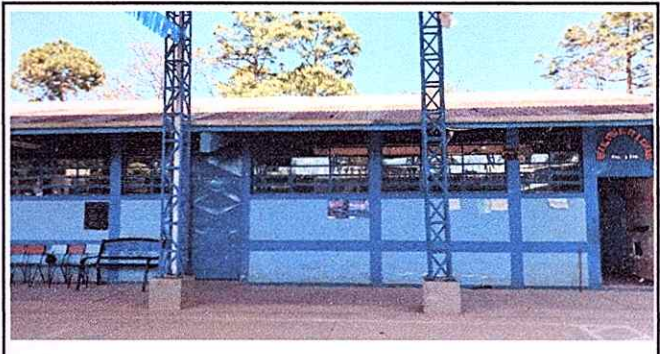
Foto 2: Sustitución de canales PVC y colocación de bajadas de agua pluvial delante de la escuela. Y elementos de fijación. Módulos 1 y 2.
