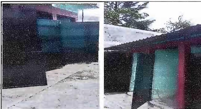
Foto 5: Sustitución de Lamina, por lamina troquelada Aluzinc calibre 26, Instalación de una costanera del baño 6x 2 pgs y Mantenimiento a estructura (aplicación de pintura y repación de las puerta)
