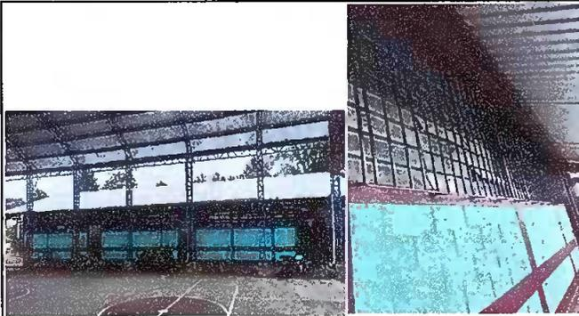
Foto 1: sustitución de lámina por lámina troquelada aluzinc calibre 26. Sustitución de vidrios e instalación balcones de metal.
