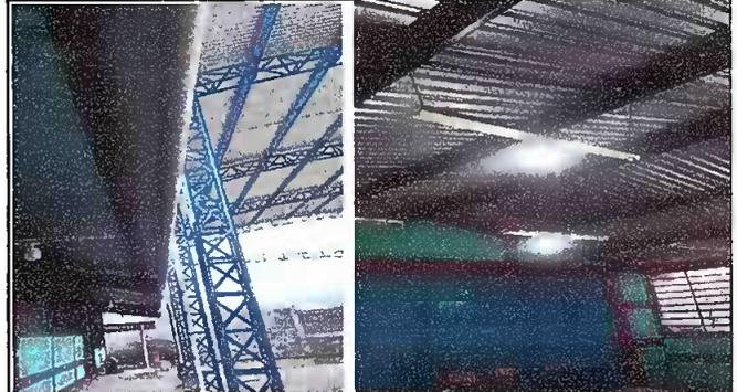
Foto 2: Instalación de canales de metal y mantenimiento de estructura (pintura) de costanera.
