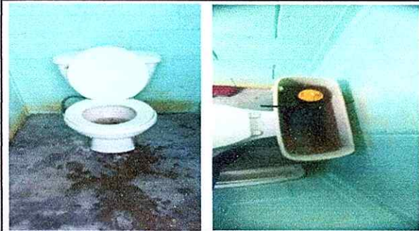
Foto 4: Sustitución de inodoros, sustitucion de accesorios de inodoros.
