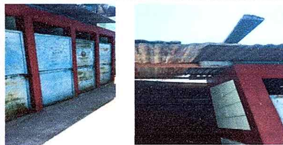
Foto 5: Sustitución de Lamina, por lamina troquelada Aluzinc calibre 26, Instalación de una costanera del baño 6x 2 pgs y Mantenimiento a estructura (aplicación de pintura y repación de las puertas)
