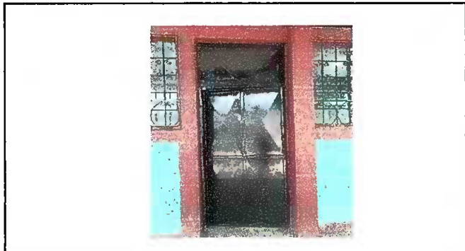
Foto 3: Modulos 1 mantenimiento de puertas
