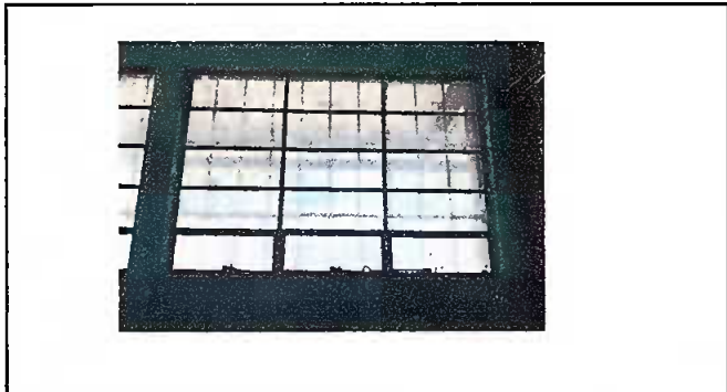
Foto 4: Modulos 1 Sustitución de vidrios
