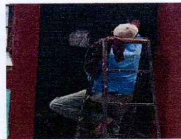
Foto 2: mantenimiento de puerta
