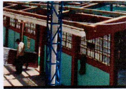
Foto 4: Modulos 1 Sustitución de vidrios
