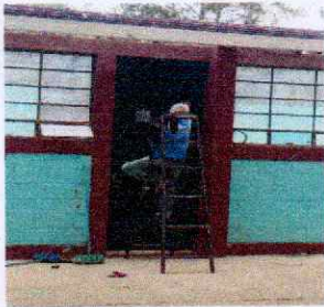
Foto 3: Modulos 1 lijado y cepillado de puertas
