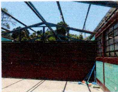
Foto 5: Modulo 1 Mantenimiento de soporte de techo
