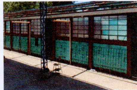
Foto 6: Modulo 1 Mantenimiento de balcones
