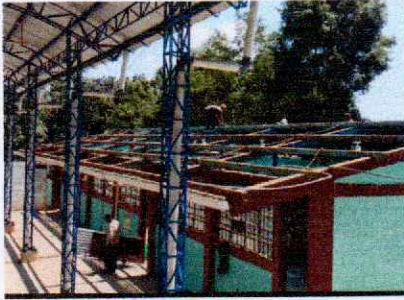
Foto1: Modulo 1 sustitución de lámina
