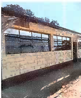
Foto 5: cambio de costanera
