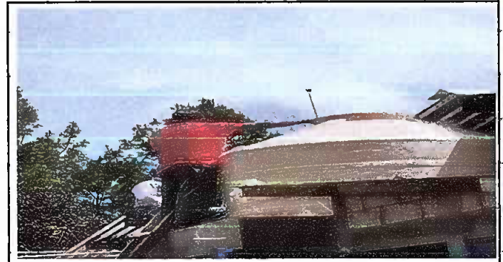
Modulo 3: Foto 4 Sustitución de depósito de agua
