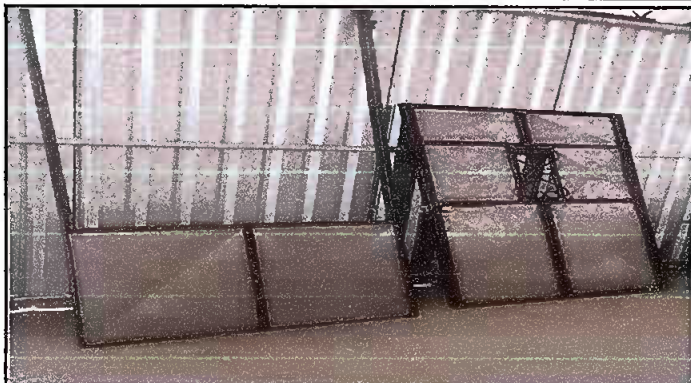
Modulo 1: Foto 1 Sustitución de puerta
