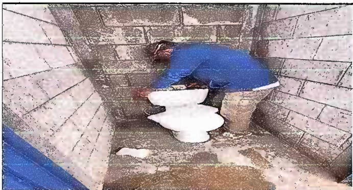
Modulo 3: Foto 3 Sustitución inodoro
