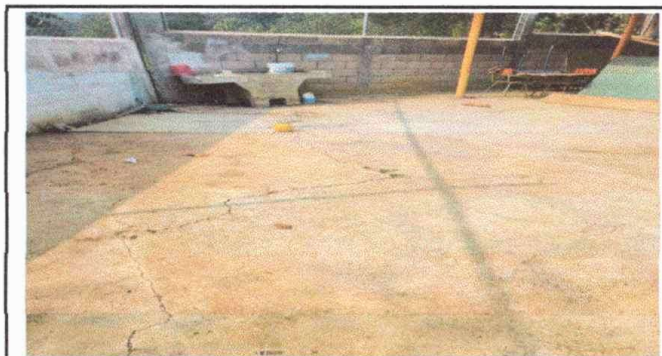
Patio. Foto 6 Reparacion de planta de concreto de patio
