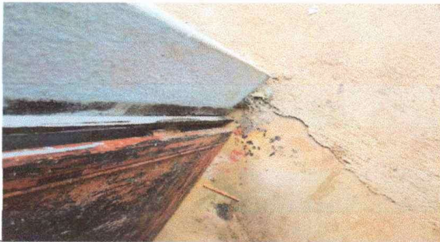
Modulo 1: Foto 1 Sustitución de puerta
