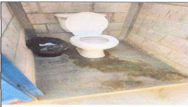
Modulo 3. Foto 3 Sustitucion inodoro
