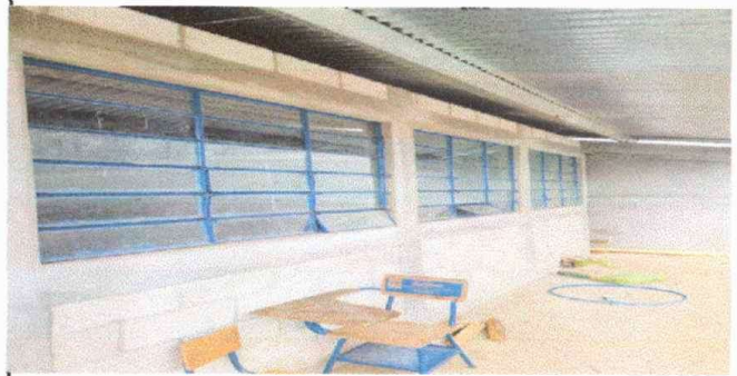
Modulo 2: Foto 2 Fabricación e instalación de blcn de hierro en ventuana
