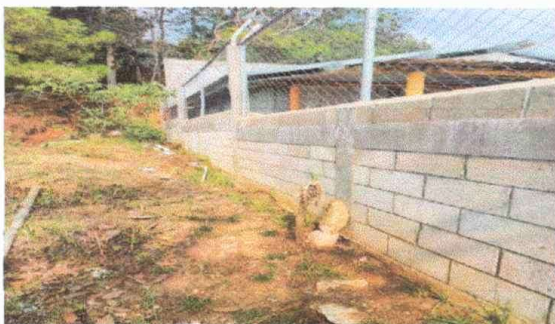
Muro Perimetral: Foto 5 repello en muro
