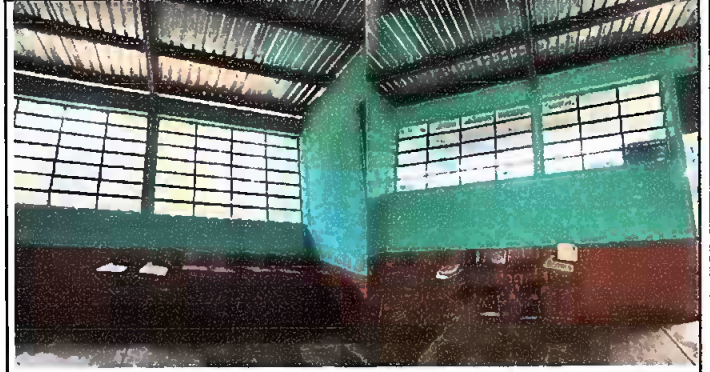
Foto 2: cambio de techo
