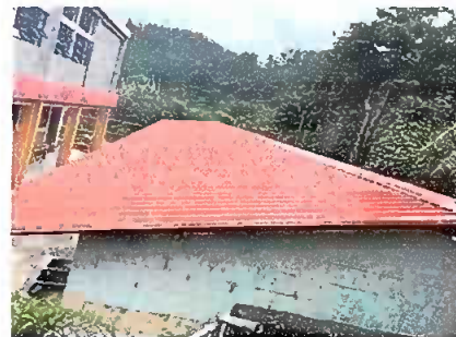
Foto 2: Cambio de techado
