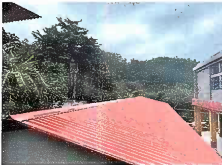
Foto 1: Cambio de techado módulo No.1
