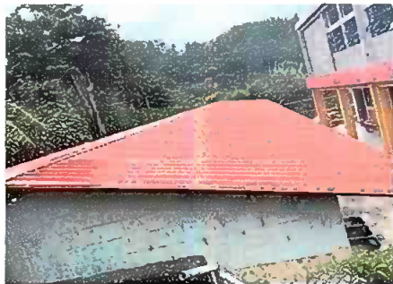
Foto 3: Cambio de techado
