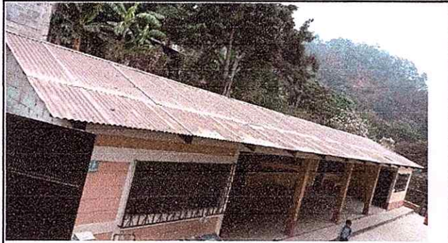
Foto 1: Cambio de techado módulo No.1
