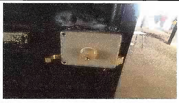
Módulo 1: Sustitución de Chapa
