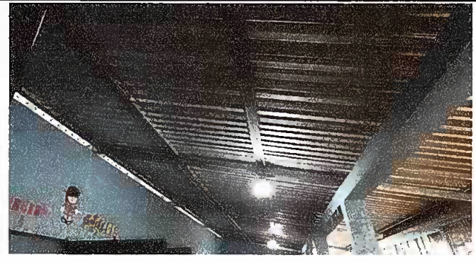
Módulo 1: Sustitución de de estructura de soporte de madera por metal
