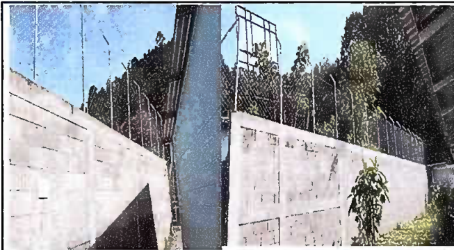
Foto 3: Reparación de muro perimetral de block con tubo hg y malla galvanizada, soleras intermedias y columnas.
