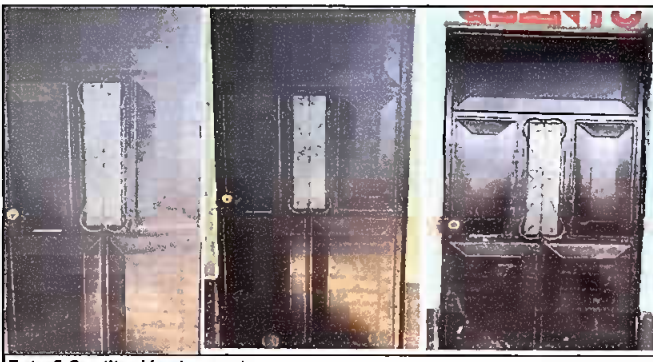
Foto 5:Sustitución de puertas
