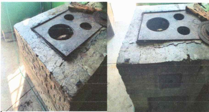
Foto 5: Sustitución de plancha de metal de tres hornillas.
