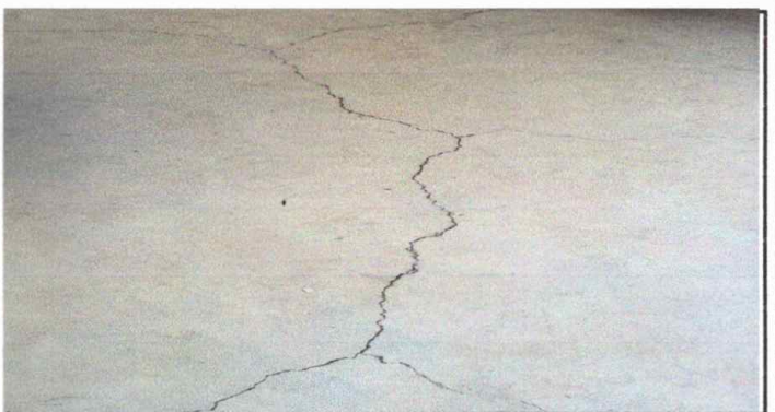
Foto:6: Reparación de piso de cemento liquido en la cocina del establecimiennto.
