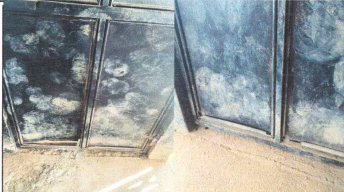
Foto1: Sustitución de puerta de metal por deteriorio del pasar de los años.
