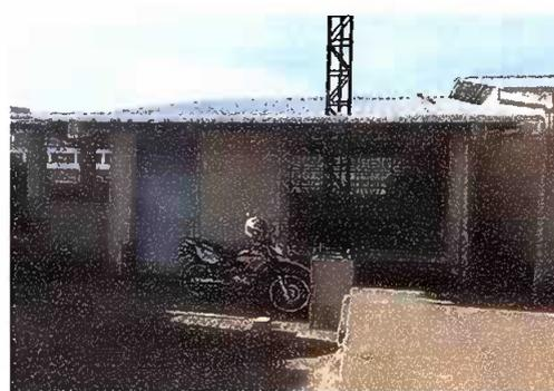
Modulo 2: Sustitución de lámina, por lámina troquelada aluzinc calibre 26, sustitución de capote de lámina para lámina troquelada, sustitución de elementos de fijación (tornillos), sustitución de canal PVC, reparación de bajada de agua pluvial, tubo PVC 3"
