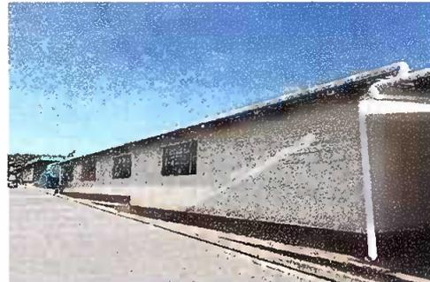
Modulo 1: sustitución de bajada de agua pluvial, tubo PVC 3" y sustitución de canal de pvc 3"
