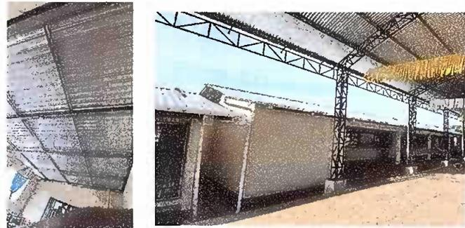
Modulo 1: sustitución de estructura de soporte de madera por metal, sustitución de lámina, por lámina troquelada aluzinc calibre 26, sustitución de elementos de fijación (tornillos) y sustitución de capote de lámina para lamina troquelada.
