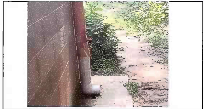
foto 2. Modulo 1: Reparación de bajadas de agua pluvial, tubo PVC 3''
