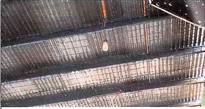
Foto 19. Modulo 6. Sustitucion de focos ahorradores
