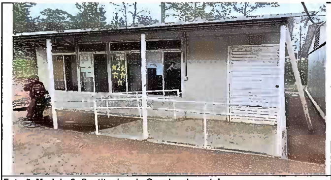
Foto 5. Modulo 2: Sustrucion de Canales de metal
