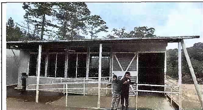
Foto 7. Modulo 3: Sustrucion de Canales de metal
