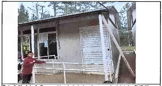
Foto 6. Modulo 2: Reparación de bajadas de agua pluvial, tubo PVC 3''
