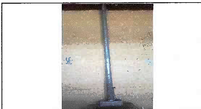
Foto 11. Modulo 4. Sustrucion de chimenea de metal por chimenea de concreto
