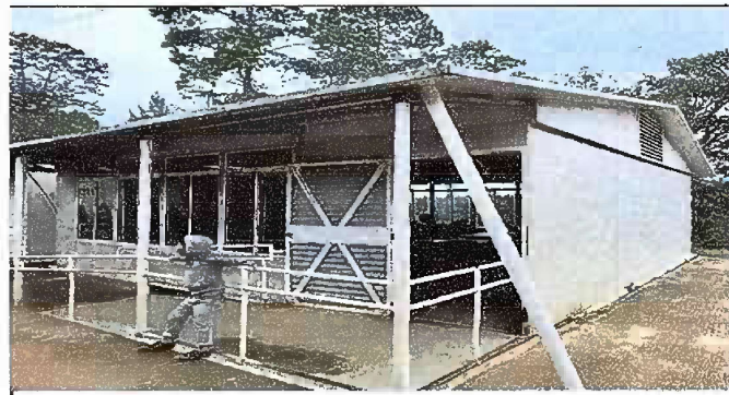
Foto 8. Moduo 3: Reparación de bajadas de agua pluvial, tubo PVC 3"
