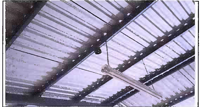
Foto 4. Modulo 1: Sustrucion de plafoneras
