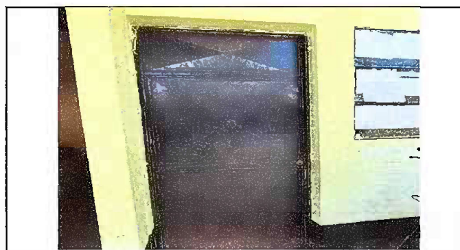
Foto 16. Modulo 5. Mantenimiento a estructura de puerta ( Lijado, pintado, cambio de tubos, sujeciones, cortado, y aplicacion de pintura)
