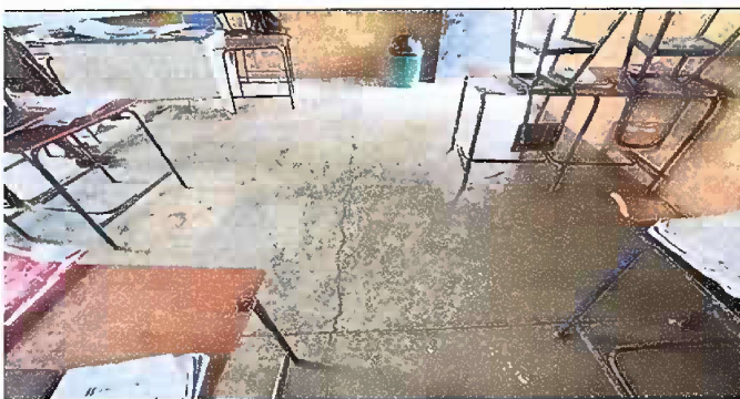
Foto 9. Modulo 4. Sustrucion de piso de torta de concreto, por piso ceramico:
