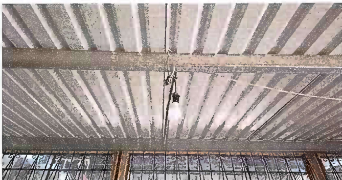
Foto 17. Modulo 5. Sustrucion de focos ahorradores
