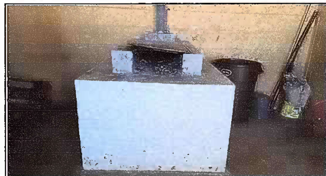
Foto 10. Modulo 4. Mantenimiento a estufa rural
