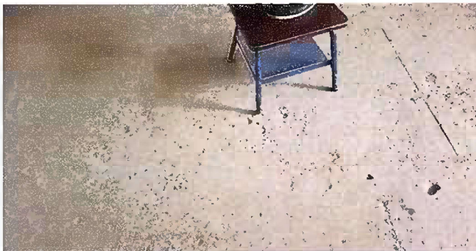
Foto 15. Modulo 5. Sustrucion de piso de torta de concreto, por piso ceramico
