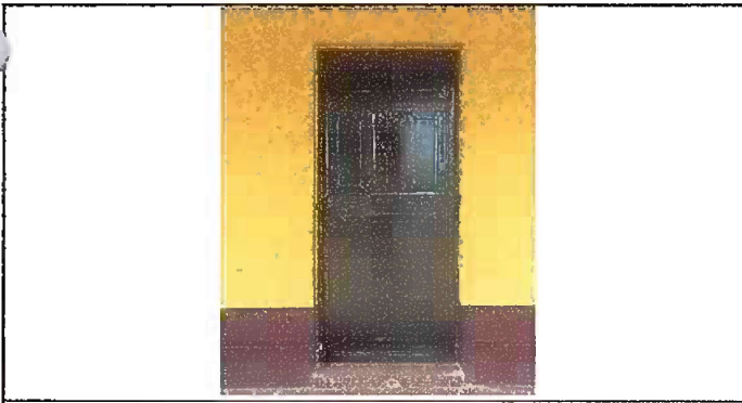
Foto 11. Módulo 2: Sustitución de puerta
