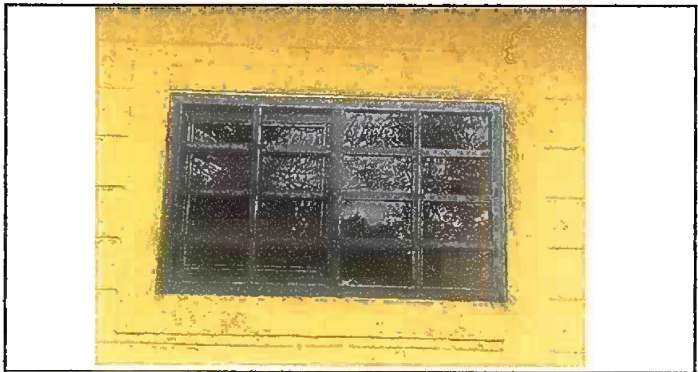
Foto 12. Módulo 2: Sustitución de ventana
