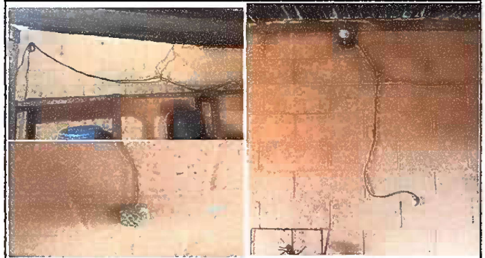
Foto 8. Módulo 2: Reparación del cableado eléctrico, sustitución de interruptores y sustitución de tocarrientes.
