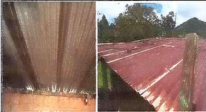
Foto 7. Módulo 2: Sustitución de estructura de soporte de madera por metal y Sustitución de lámina por lámina troquelada aluzinc calibre 26
