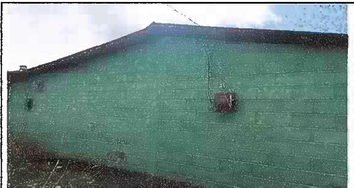
Foto 6. Módulo 1: Levantado de mojinete, altura 0.40 m
