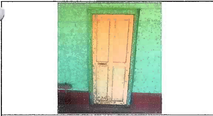
Foto 11. Módulo 2: Sustitución de puerta
