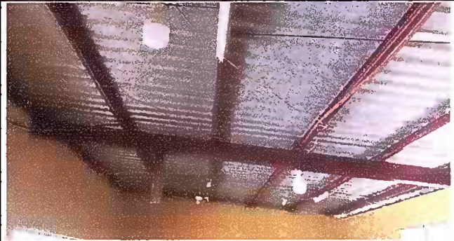
Foto 8. Modulo 1: Mantenimiento a estructura de soporte de metal
