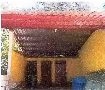
Foto 9. Modulo 1: Sustitución de estructura de soporte de metal, por metal
