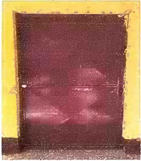
Foto 7. Modulo 1: Sustitución de puerta
