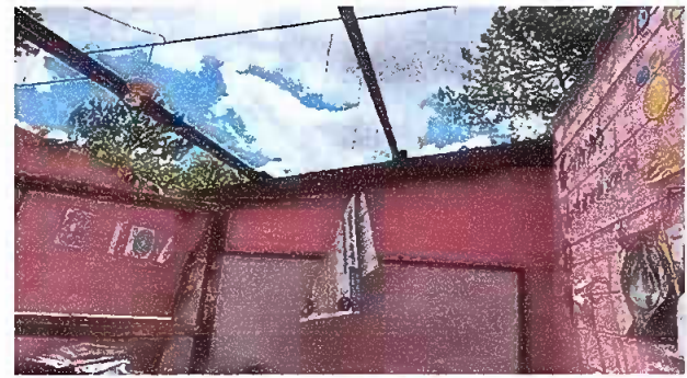
Foto 8. Modulo 1: Mantenimiento a estructura de soporte de metal
