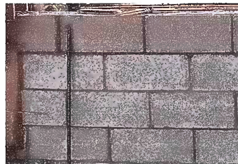
Foto 10. Modulo 1: reparacion de pared deblock
