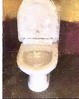
Foto 14. Modulo 1: Sustitución inodoro
