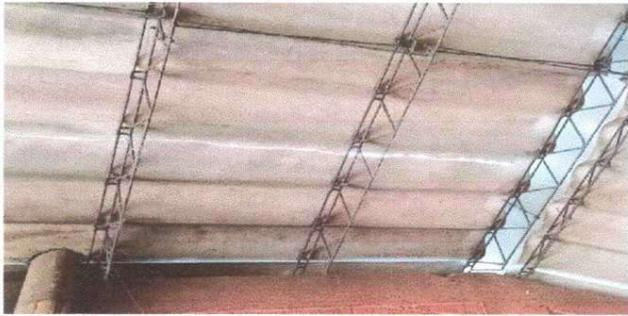
**foto 1. Modulo 1: Sustitución de lámina por lamina troquelada aluzinc calibre 26**
