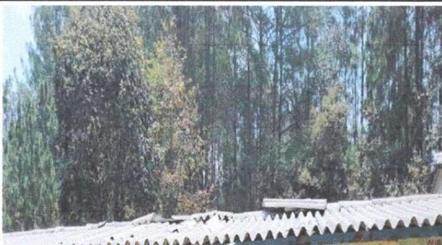
**Foto 3. Modulo 1: Sustitución de capote calibre 26 para lamina troquelada**
