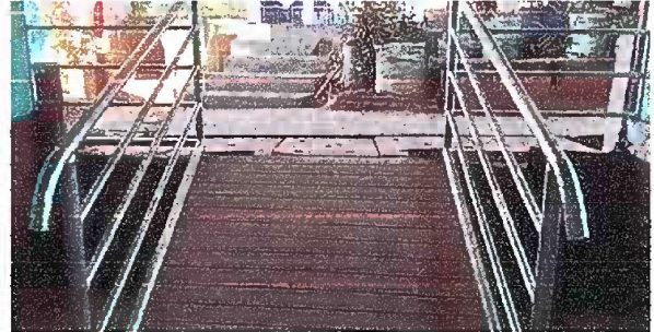
MODULO 1: FOTO. 2 SUMINISTRO E INSTALACION DE BARRANDAS DE METAL
