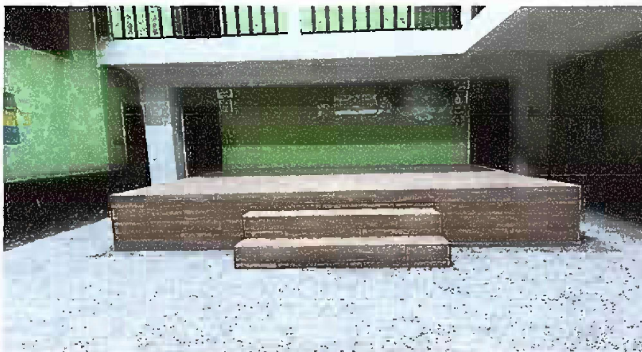
Foto 5: Sustrucción de piso de cerámico.
