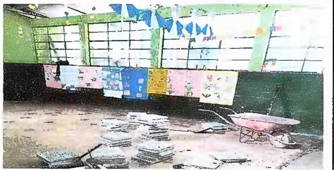
Foto 6: Sustitución de piso de granito.
