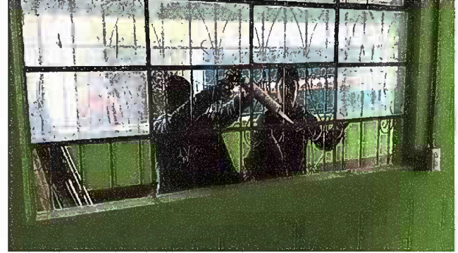
foto 2. Modulo 1: Ssustitucion de vidrios
