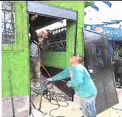
Foto 3. Modulo 1: Sustitución de puerta
