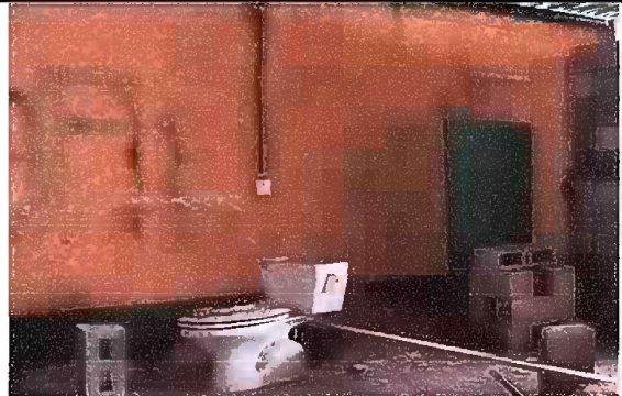
Foto 6. Modulo 1: Sustitucion de inodoro
