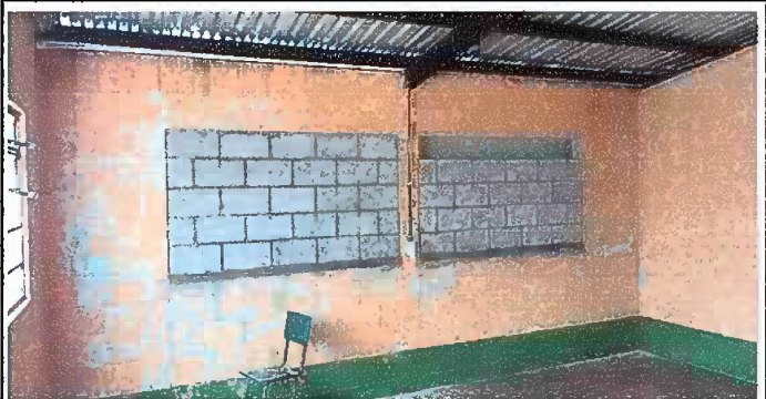
Foto 4. Modulo 1: reparacion de pared de block
