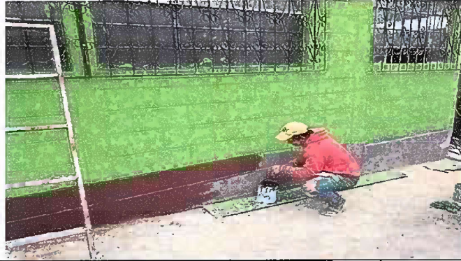
foto 1. Modulo 1: Pintura de paredes interiores y exteriores
