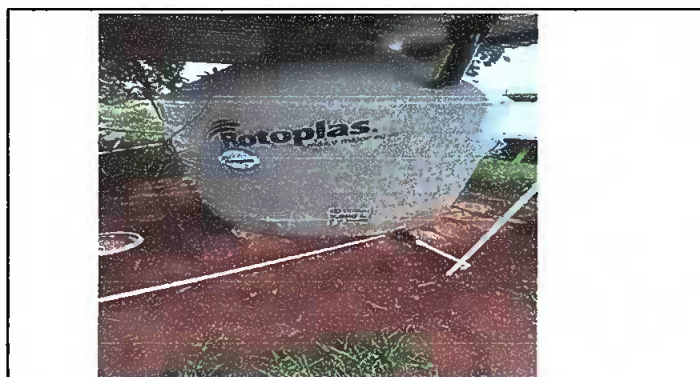
Foto 10: MODULO 2. Deposito de agua ya en funciones.
