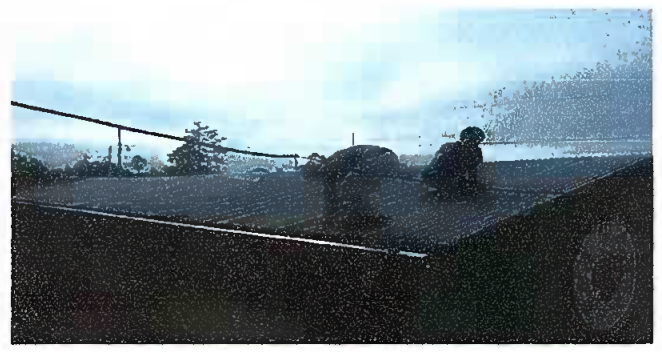
Foto 2: MODULO 1. Se retiran los respectivos tornillos para poder retirar las laminas; para luego sustituirlas por las laminas troqueladas aluzinc.
