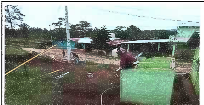
Foto 6: MODULO 2. Se procede a la sustitucion de lamina, por lamina troquelada.
