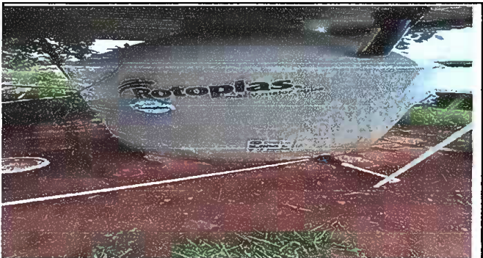
Foto 10: MODULO 2 . Se procede a la instalacion de rotoplas.
