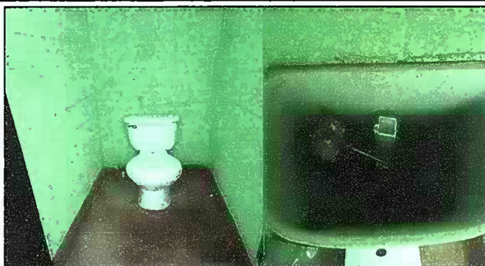
Foto 8: MODULO 2, sustitución de inodoro e instalación.
