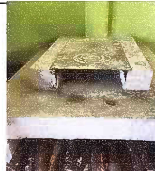
Foto 12. Módulo 2: Sustitución de estufa rural (completa incluye chimenea y plancha de metal)
