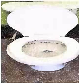
Foto 7. Módulo 1: Sustitución inodoro
