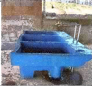
Foto 13. Modulo 2: Sustitución de pila de cemento de dos lavaderos
