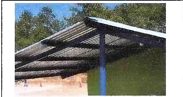
Foto 3. Modulo 1: Sustitución de capote para lamina troquelada
