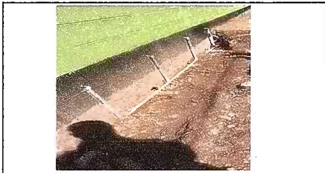
Foto 5. Modulo 1: Sustitución de tubería línea principal
