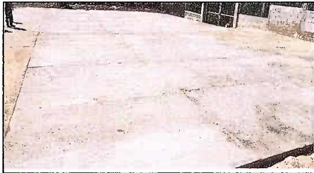
Foto 14. Modulo 3 :Reparacion de planchas de concreto de patio
