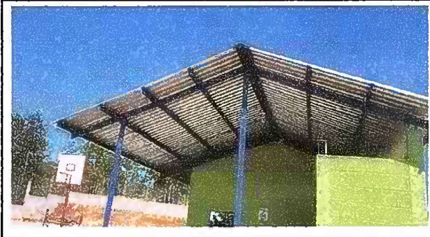
Foto 4. Modulo 1: Sustitucion de estructura de soporte de madera, por metal
