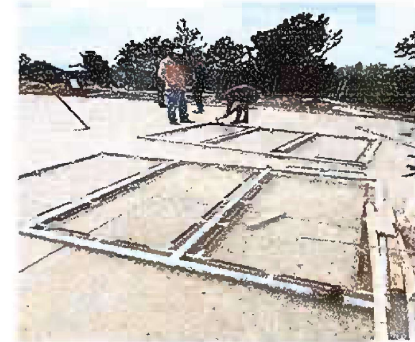
Foto 16. Modulo 4: Mantenimiento a porton de metal
