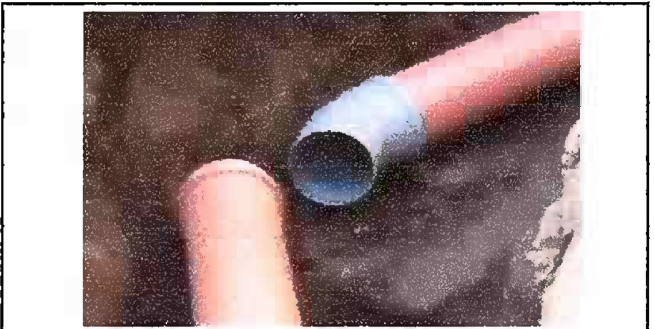
Foto 6. Modulo 1 Sustitucion de tuvería de pvc línea principal de aguas negras
