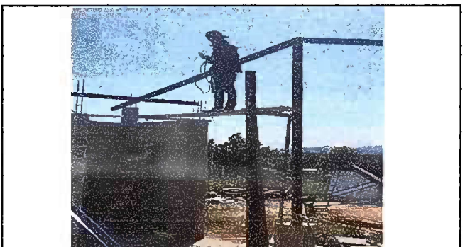
Foto 4. Modulo 1: Sustitucion de estructura de soporte de madera, por metal
