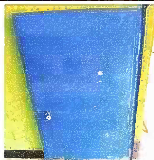
Foto 10. Modulo 2: Mantenimiento a estructura de puerta (lijado, y aplicón de pintura)
