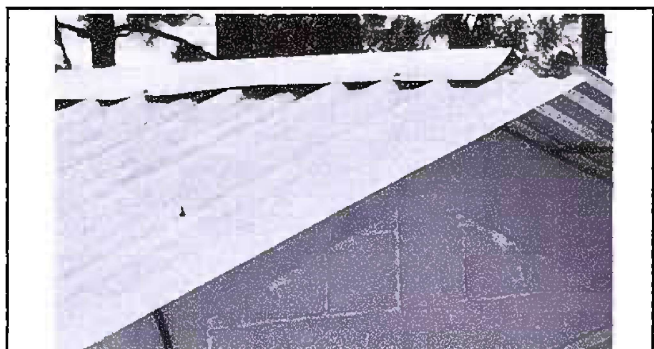
Foto 3. Modulo 1: Sustitución de capote para lamina troquelada
