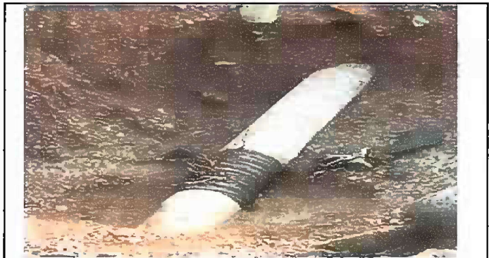
Foto 6. Modulo 1 Sustitucion de tuveria de pvc línea principal de aguas negras
