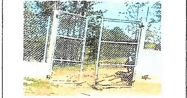
Foto 16. Modulo 4: Mantenimiento a porton de metal
