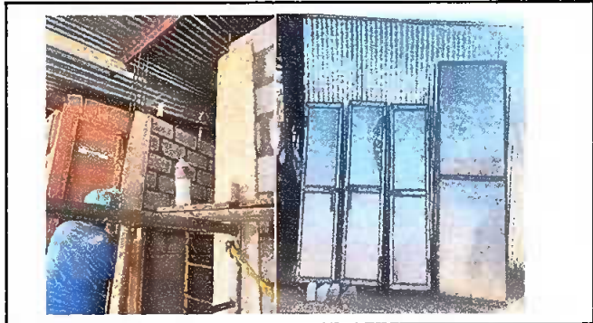
MÓDULO 1: Sustitución de puerta de madera por puerta de metal. Sustitución de ventanas de madera por metal más vidrio.
