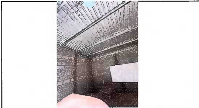
MÓDULO 1: Sustitución de lámina, por lámina troquelada aluzinc calibre 26. Sustitución de capote de lámina para lámina troquelada. Sustitución de elementos de fijación. Sustitución de estructura de soporte de metal por metal.
