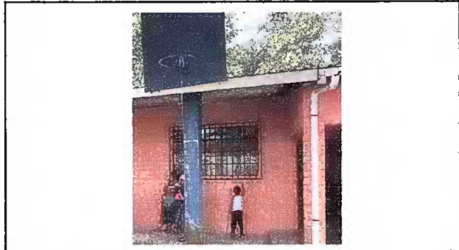
MÓDULO 1: Pintura en muros interiores y exteriores..
