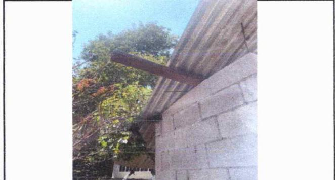
**MÓDULO 2:** Sustitución de lámina, por lámina troquelada aluzinc calibre 26. Sustitución de elementos de fijación.
