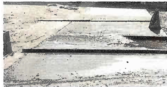
Foto 6. Patio No. 1: Reparación de planchas de concreto de patio
