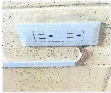
Foto 16. Modulo 3. Sustitución de tomacorrientes dobles
