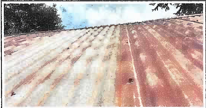
foto 2. Modulo 1: Sustitución de capote (maxalum calibre 26 para lamina troquelada)
