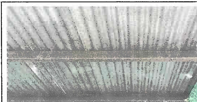
Mantenimiento a estructura de soporte de metal
