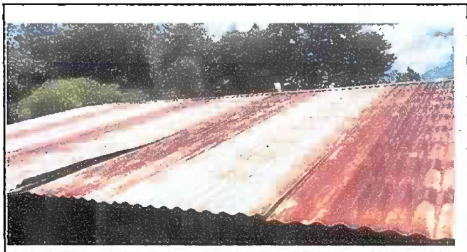
Foto 4. Modulo 1: desinstalacion de lamina existente
