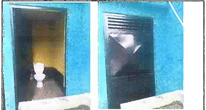
Foto 4: Módulo 2. Suministro e instalación de puertas en servicios sanitarios. Mantenimiento a puertas de servicios sanitarios.
