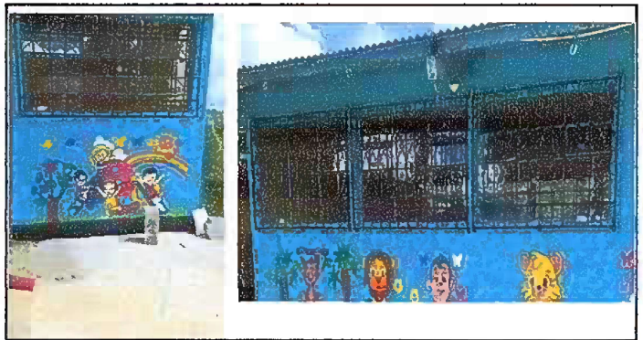
Foto 6: Módulo 3. Suministro e Instalación de Balcones de hierro en ventanas.
