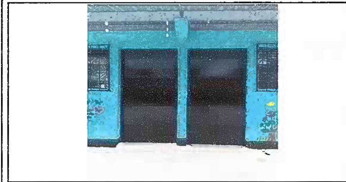
Foto 5: Módulo 3. Mantenimiento a estructura de puertas
