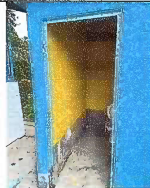
Foto 4: Módulo 2. Suministro e instalación de puertas en servicios sanitarios. Mantenimiento a puertas de servicios sanitarios.
