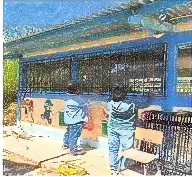
Foto 1: Módulo 1. Suministro e Instalación de Balcones de hierro en ventanas.
