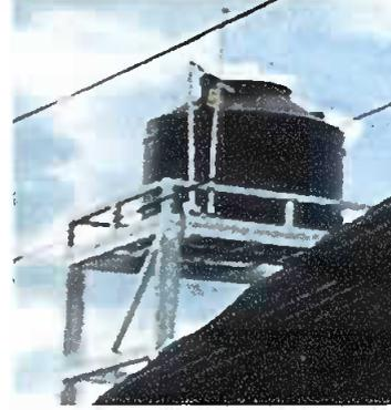
Foto 2: PATIO; Sustitución de base de metal para tinaco
