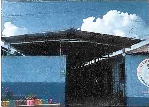
Foto 1: Patio: Sustitución de lamina por lamina troquelada aluzinc y sustitución de estructura de soporte de metal por metal
