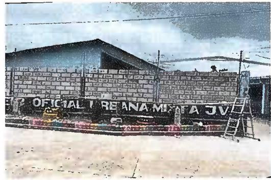
Foto 6: Muro perimetral. Reparación de muro de block .
