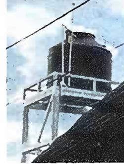
Foto 2: PATIO; Sustitución de base de metal para tinaco
