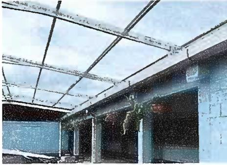
Foto1: PATIO: Sustitución de lamina por lamina troquelada aluzinc y sustitución de estructura de soporte de metal por metal
